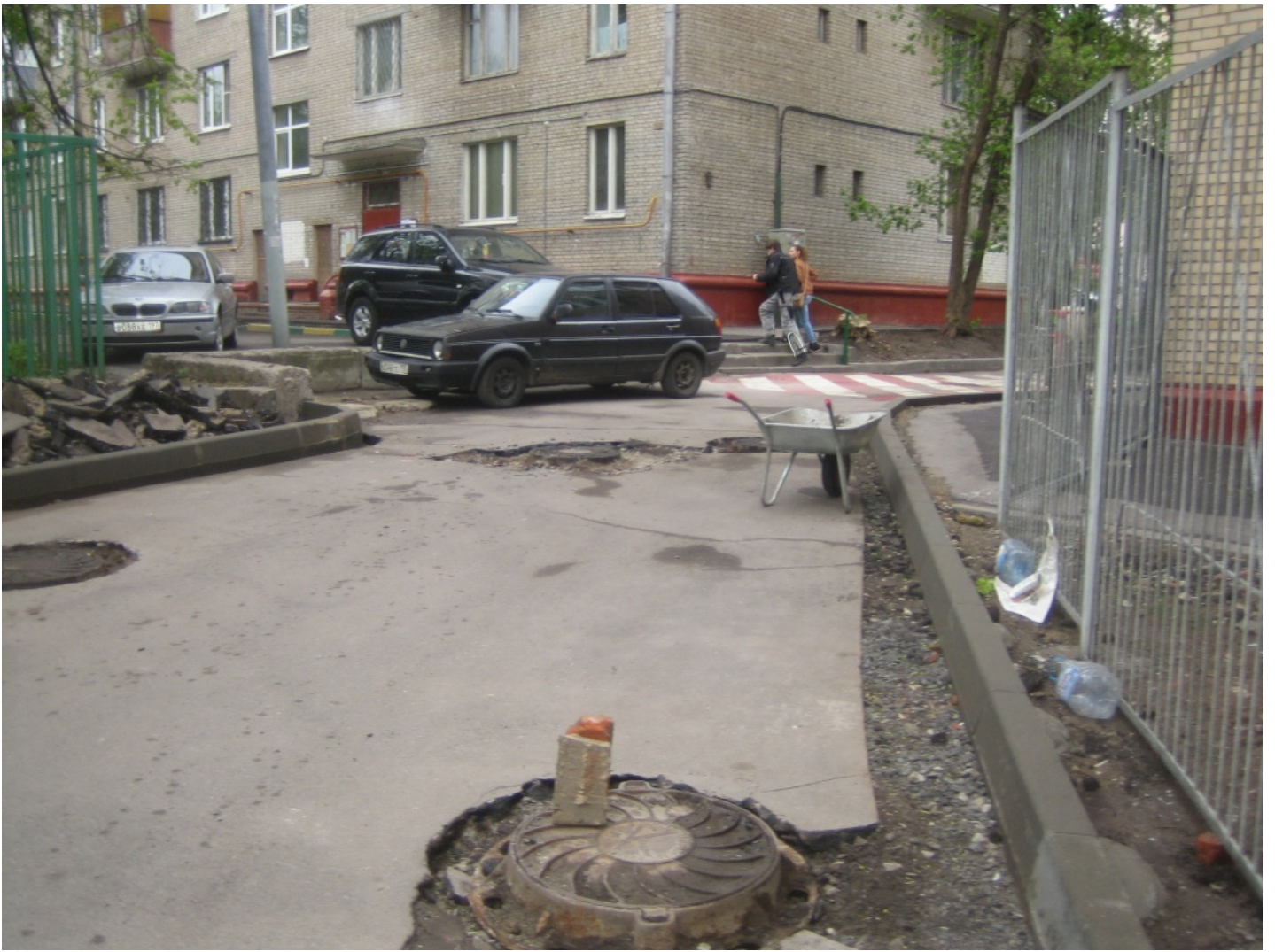
После проведения ремонтных работ
